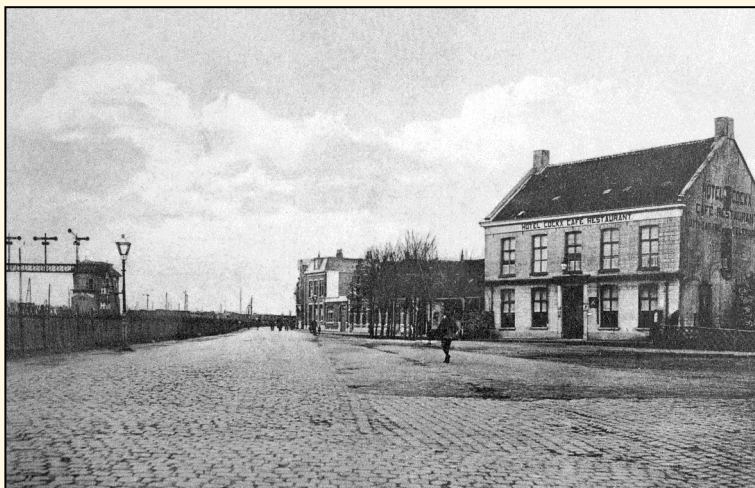
Na de afbraak van het oude stationscomplex kwam het 'Hotel Cockx' geheel vrij te staan op het Oranjeplein. Links op de prentbriefkaart ziet men het seinhuis A, dat in oktober 1944 werd opgeblazen en vervangen door een naoorlogse constructie. Het 'Hotel Cockx' verloor in 1919 zijn bestemming als hotel, café en restaurant. Ansichtkaart uit circa 1910, collectie Marius Broos.
